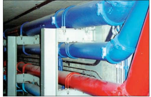
Las tuberías GIC pueden pintarse o recubrirse con polvo por motivos de seguridad. Como las piezas se sumergen completamente en zinc fundido, este las protegerá por dentro y por fuera
