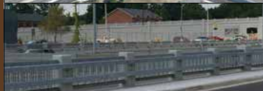
Reconstrucción de puente ferroviario M-102 Detroit, Michigan
