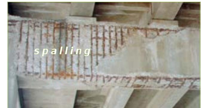
rogné dans une région de la barre que la corrosion de l'acier commence. Des études et des informations complémentaires sur les armatures d'acier en barres galvanisées se trouvent dans le site Web [www.galvanizedrebar.com](http://www.galvanizedrebar.com) et dans la publication de l'AGA, *Hot-Dip Galvanized Reinforcing Steel: A Specifier's Guide* ou sur le site Web de l'AGA [www.galvanizeit.org](http://www.galvanizeit.org).
